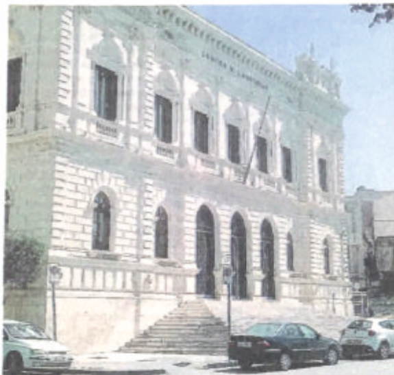
Il palazzo che ospita gli uffici della Camera di commercio
