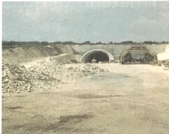
Un'immagine del cantiere sulla Siracusa-Gela (*FOTO PID*)
