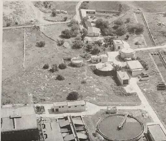
LA ZONA IN CUI SORGE IL DEPURATORE DI CONTRADA MAGANUCO
