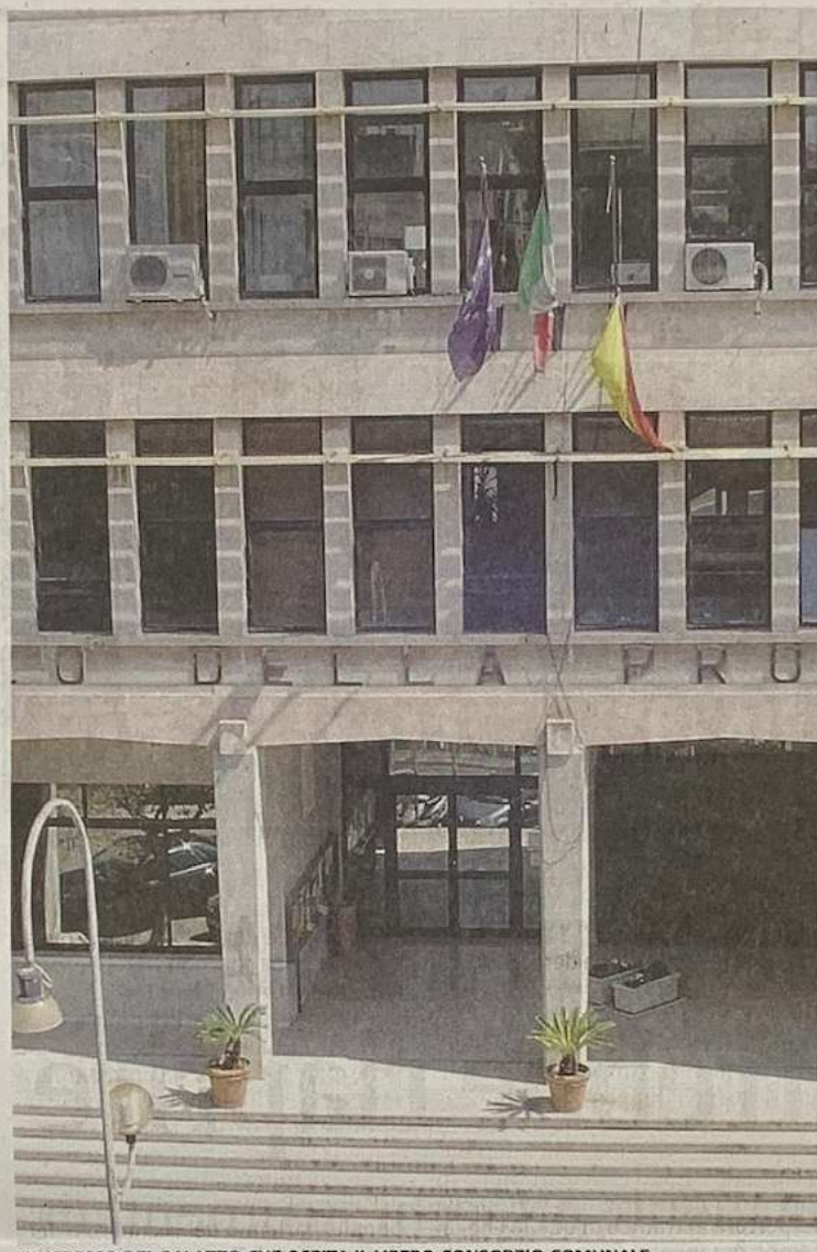
L'INGRESSO DEL PALAZZO CHE OSPITA IL LIBERO CONSORZIO COMUNALE
