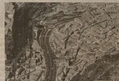
L'ARRIVO. In via Marchesa Tedeschi la tappa finale del tunnel da realizzare con i fondi di Agenda urbana
