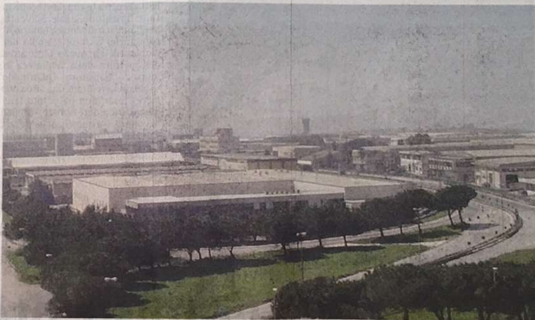
La Zes potrà prendere in considerazione anche eventuali aree attrezzate sottoutilizzate. Nella foto, la zona industriale di Ragusa
