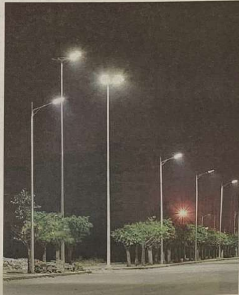
Circolazione. Una delle strade illuminate con lampade a led
