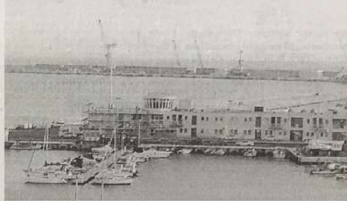
Il porto di Pozzallo
