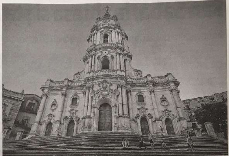
Il duomo di San Giorgio, all'interno è stata installata una rete di sicurezza per mettere al riparo da altri cedimenti
