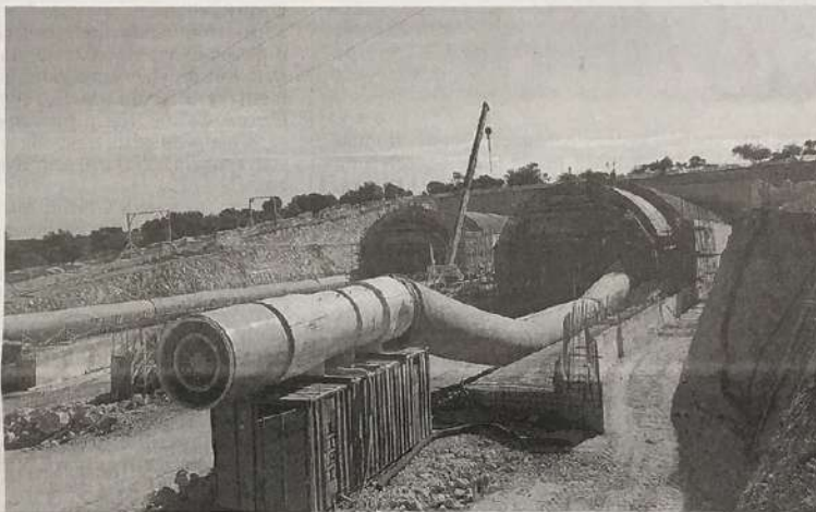
Il cantiere per la realizzazione della Rosolini-Modica.
