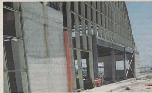
Il cantiere della stazione passeggeri del porto di Pozzallo
