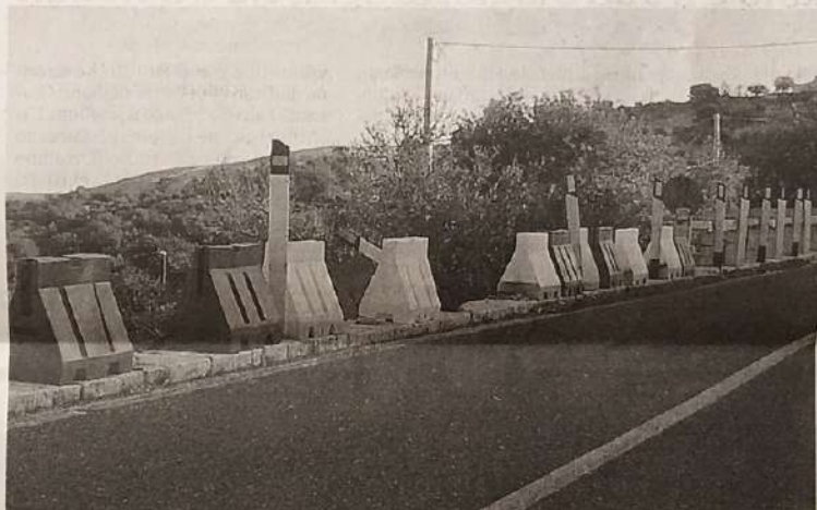
Uno dei tratti dell'arteria stradale interessato dai lavori.
