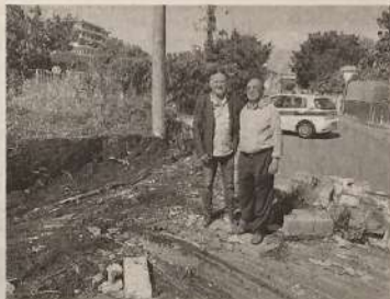
I lavori d'ampliamento della carreggiata in corso in contrada Campanaro
