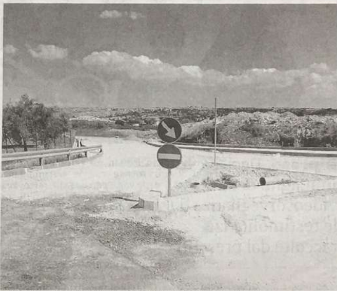
LAVORI IN CORSO NELL'AREA DELLO SVINCOLO DI DENTE-CROCICCHIA
