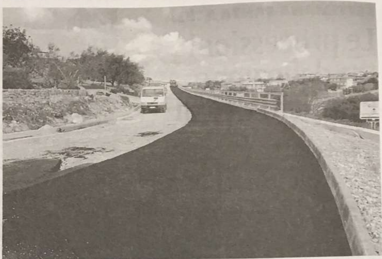
L'OPERA INFRASTRUTTURALE DEL QUARTIERE DENTE PROCEDE VERSO LA CONSEGNA
