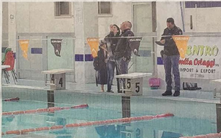
L'intervento della polizia per capire cosa era accaduto. Nel riquadro, una delle zone interessate dal distacco dei listelli di legno dal tetto
