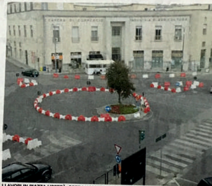
I LAVORI IN PIAZZA LIBERTÀ. SOPRA, L'ASSESSORE SALVATORE CORALLO
