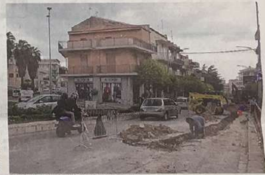
LAVORI IN CORSO LUNGO LA VIA ARCHIMEDE
