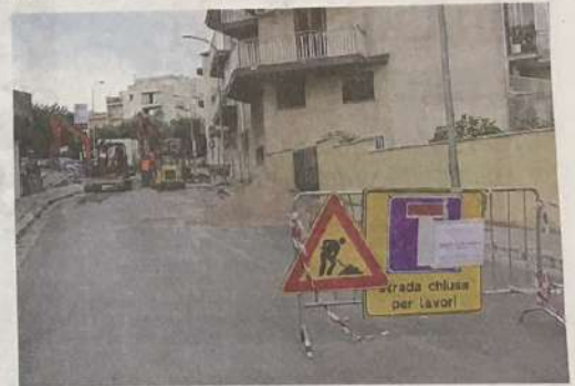
LAVORI IN CORSO-VIA MONGIBELLO (1)
