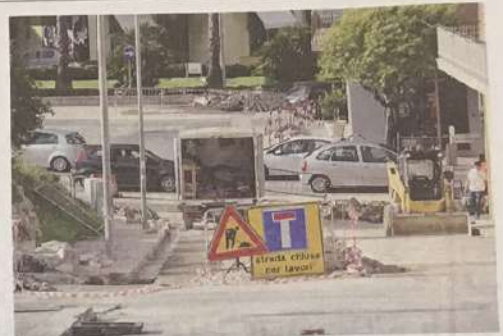
LAVORI IN CORSO-VIA BELLARMINIO
