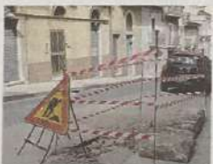
LAVORI ANCHE IN VIA SANT'ANNA, IN PIENO CENTRO STORICO SUPERIORE.
