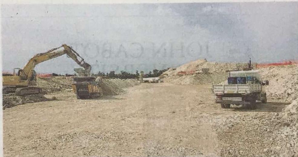
Il cantiere dell'autostrada nel tratto tra Rosolini e Modica
