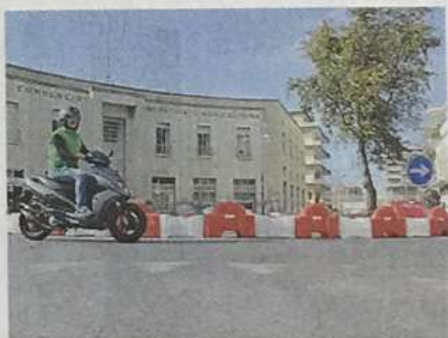
I LAVORI IN PIAZZA LIBERTÀ
